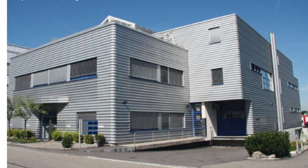
Hauptsitz Rehatec, Ringstrasse 15, Allschwil
